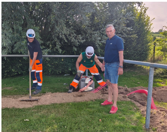
Tranchée effectuée par EITF pour l'éclairage en LED du terrain officiel de football.
