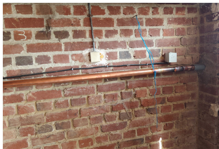
Remplacement du tuyau de gaz de l'école par le prestataire NP Energies.
