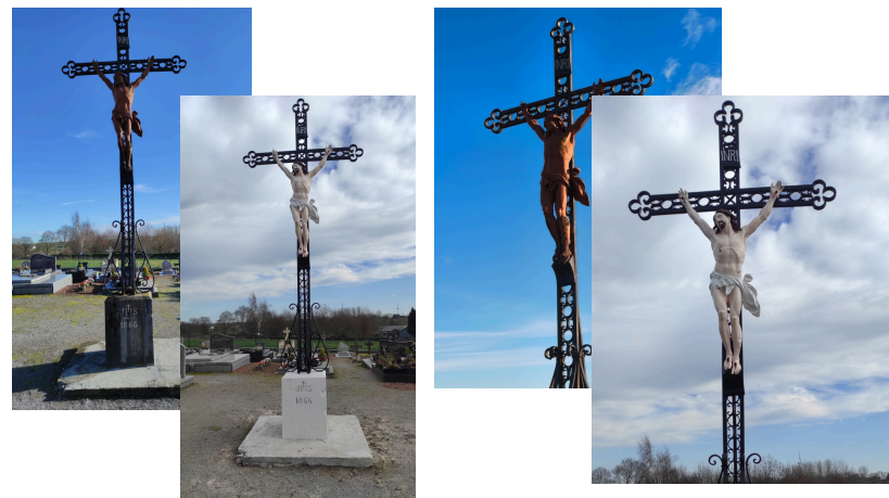
Restauration du Christ au cimetière.
